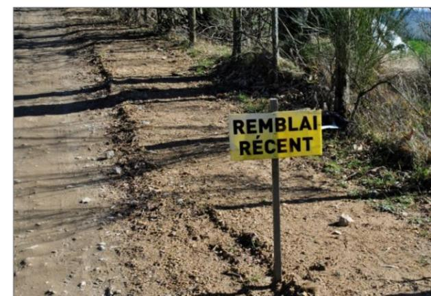
Photographie 30 : Exemple de remblai des tranchées électriques le long d'une piste (Source : ENCIS Environnement)
