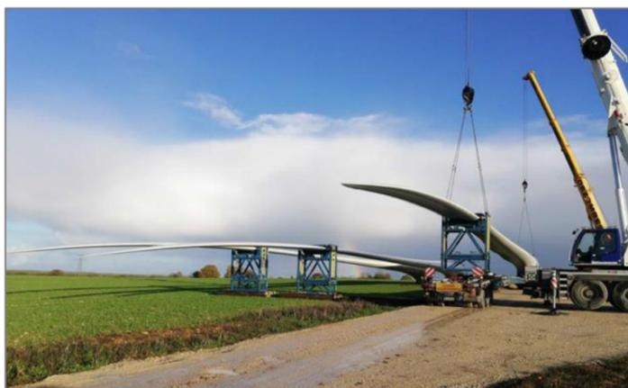
Photographie 31 : Stockage des pales en phase construction (Source : NCA Environnement)
