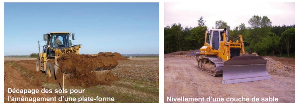
Photographie 26 : Exemples d'engins de travaux de VRD
