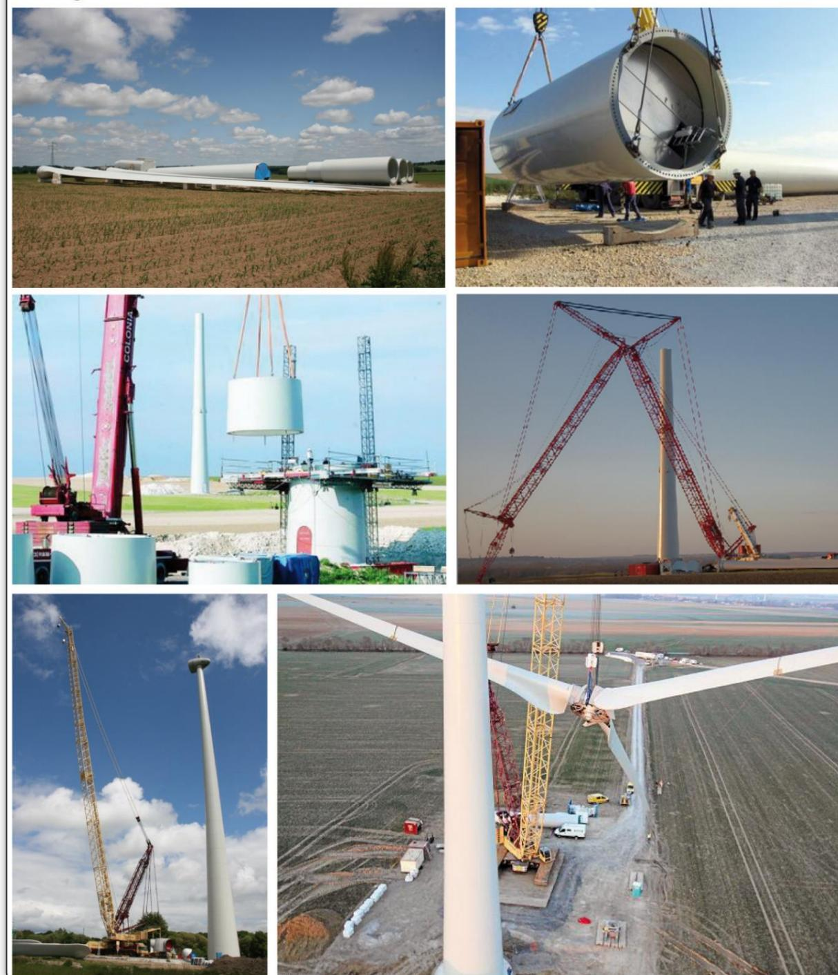
Photographie 29 : Phases d'assemblage d'une éolienne
