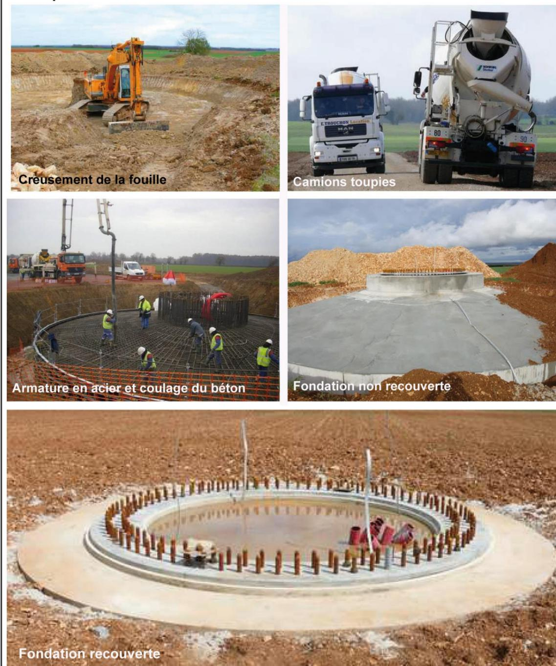
Photographie 27 : Étapes de réalisation d'une fondation d'éolienne
